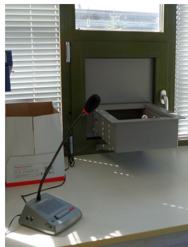
Modernizacja otwieranego wcześniej okienka - podajnik zamontowany w miejscu wcześniejszej szyby – widok od wewnątrz pomieszczenia
