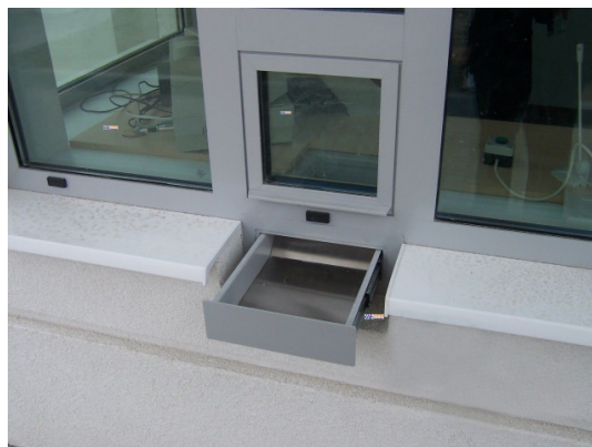
Podajnik zamontowany w murze pod oknem
