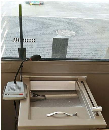
Interkom OPTIMUS zainstalowany na w witrynie kasowej z podajnikiem szufladowym (szufladą podawczą)
